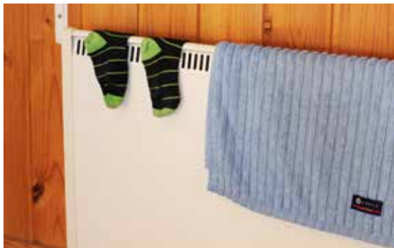
Älä kuivata vaatteita sähkölämmittimen päällä.
