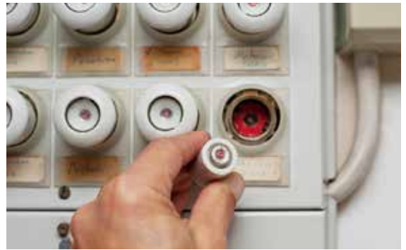
Sulakkeen koko selviää sulakkeen merkinastan tai varokepesän pohjakoskettimen tunnusväristä tai sulakkeen numeromerkinnöistä.
