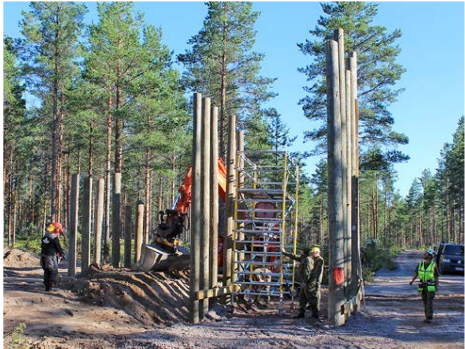
■ Telineet pystytetty, ja sillan rakentaminen voi alkaa.
