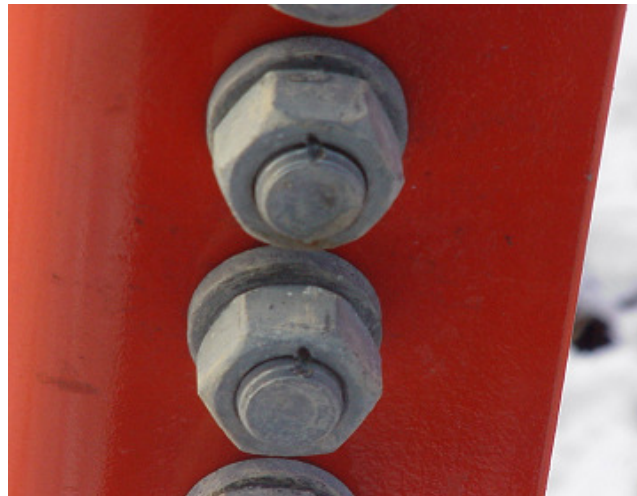
Kiristetty ja lukittu liitos
